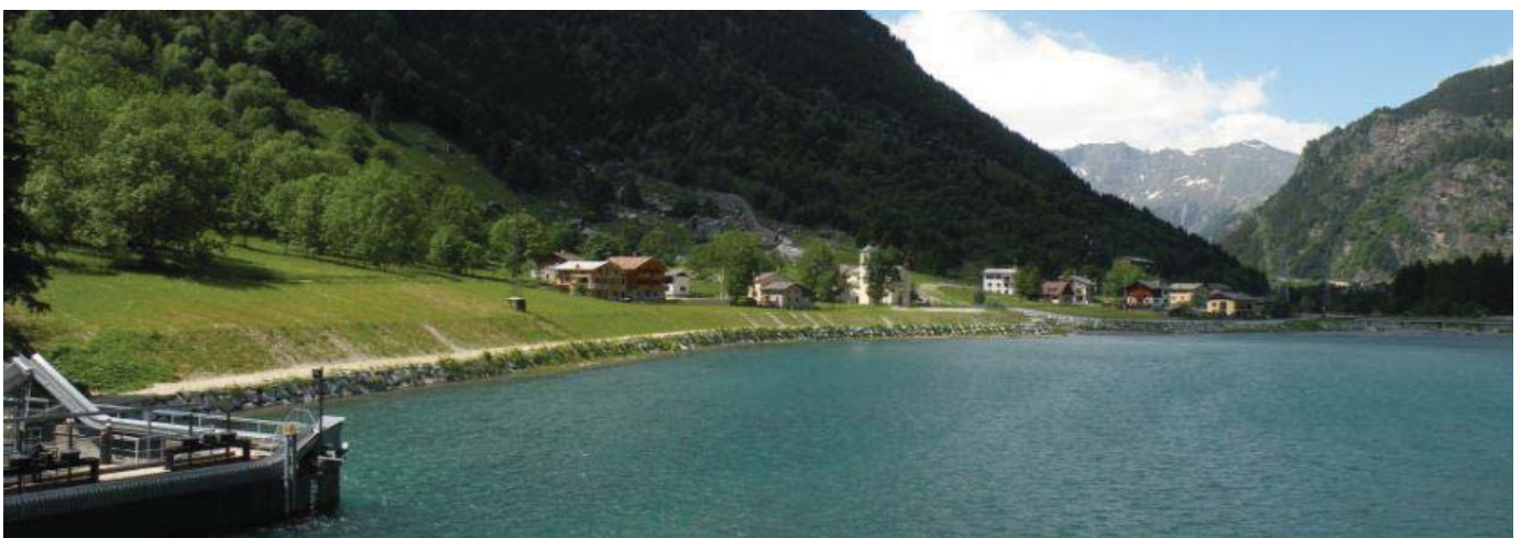
Fig. 9 - Sponda traversa Prestone terminati i lavori
