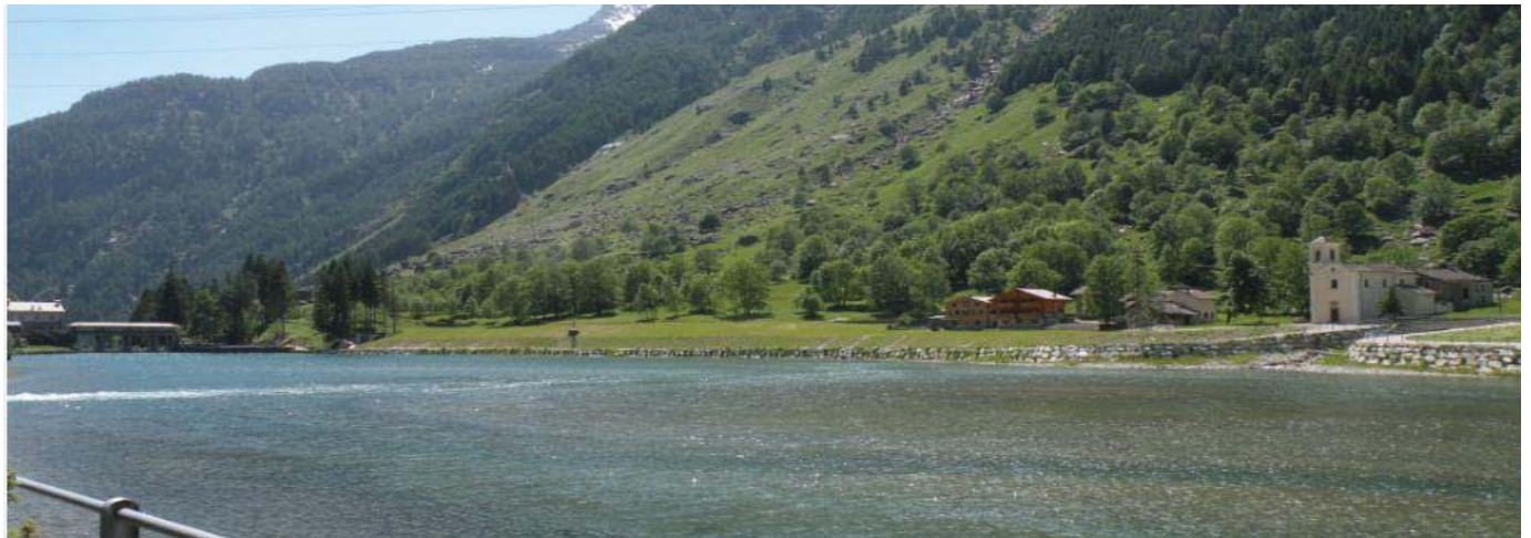
Fig. 8 - Sponda traversa Prestone terminati i lavori
