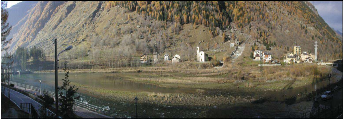
Fig. 7 - Sponda traversa Prestone prima dei lavori
