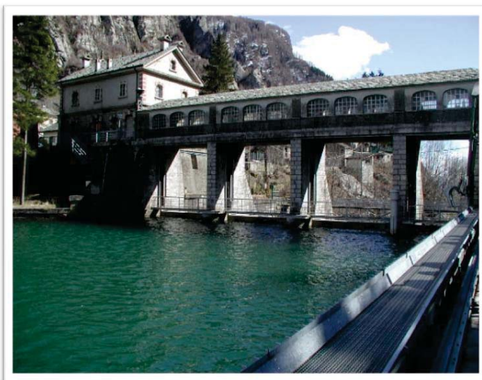
Fig. 2 - In alto: Diga Truzzo Al centro: Bacino Gorghiglio In basso: Traversa Prestone
