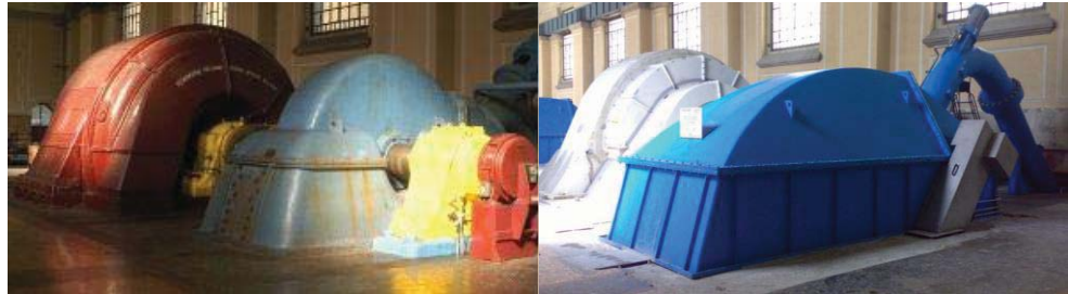
Fig. 5 – Gruppo Mese prima e dopo la sostituzione
